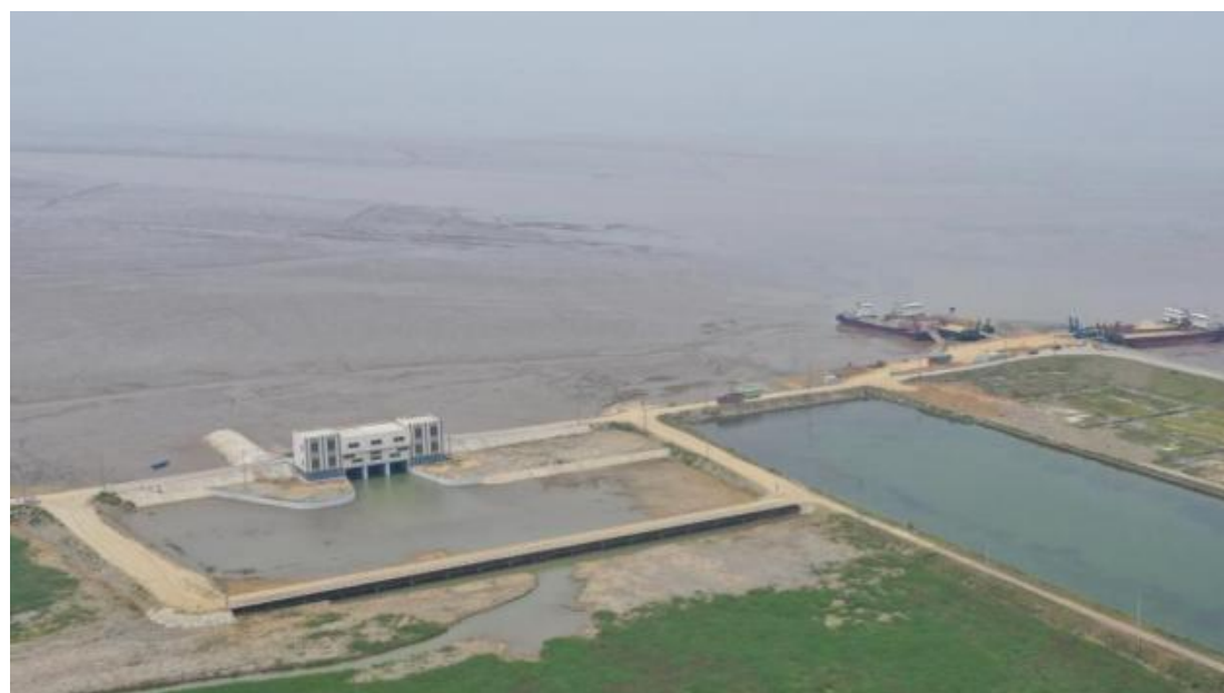
图 3.2-6 杭州湾新区十二塘纳排闸
