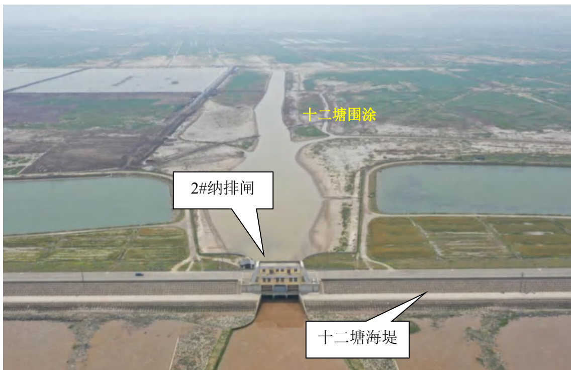
图 3.2-8 杭州湾新区十二塘 2#纳排闸
