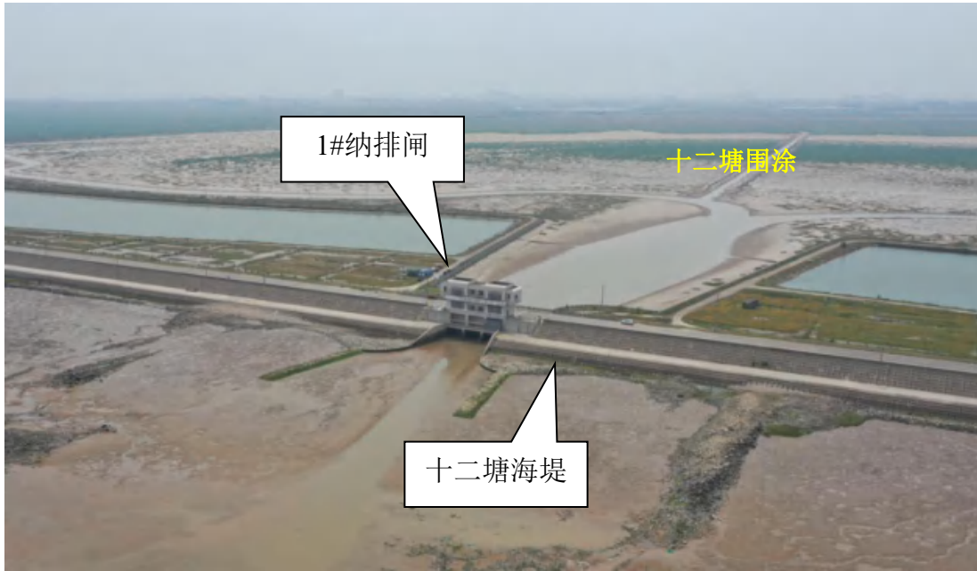
图 3.2-9 杭州湾新区十二塘 1#纳排闸
