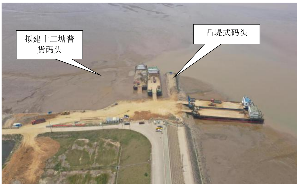
图 3.2-7 杭州湾新区十二塘西侧码头
